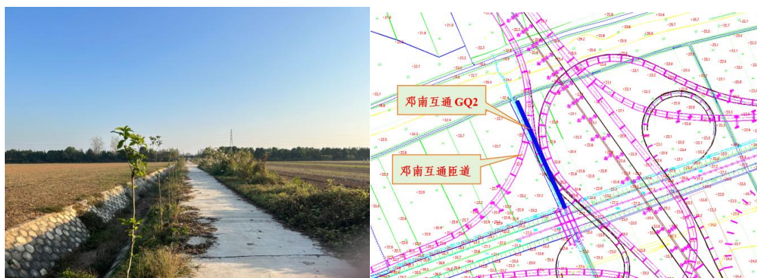
图 3.2-5 邓南互通 GQ2 现状照片
